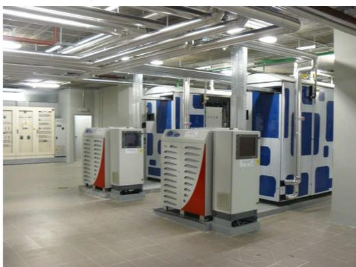
El edificio de la central se halla totalmente terminado y está previsto que suministre calefacción y ACS con la mas alta eficiencia energética, incorporando un local para una central de cogeneración (eléctrica-calor) mediante la tecnología de “PILA DE COMBUSTIBLE (Hidrogeno)”. Tiene instaladas dos calderas de condensación y dos pilas de
