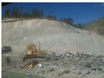
Figura 5. Compactación y conformación de la celda diaria.
