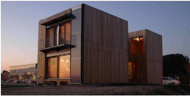
Vista del sud de la casa sin la protección solar. Estructura de madera y aislamiento de lana de oveja
