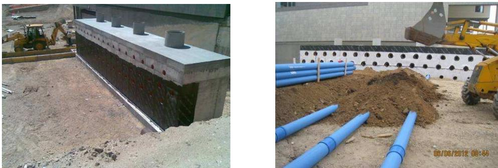
Figura 6: detalle de pozos geotérmicos (pozos canadienses) en construcción.
