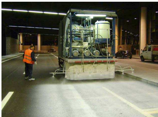
Figura 5. Aplicación de Coverlite ® , mediante el prototipo patentado por “Impresa Bacchi”, en la Terminal 1 del Aeropuerto de Malpensa (Milán).
