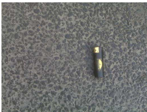
Figura 2. Percolación de lechada especial sobre la capa de mezcla bituminosa drenante
