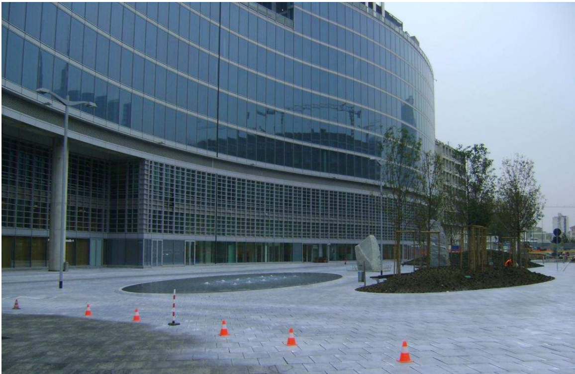
Figura 7. Aplicación de Coverlite® en las aceras del Edificio de la Región Lombardia (Milán)
