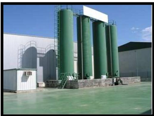
Figura 14. Tanques de almacenamiento de aceite.
