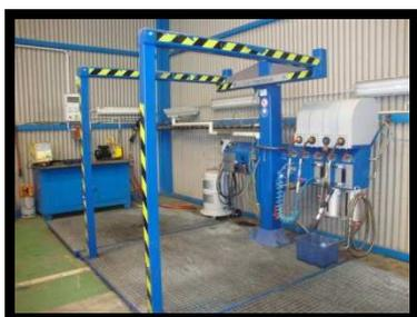
Figura 12. Maquinaria para descontaminación y extracción de líquidos en vehículos fuera de uso.
