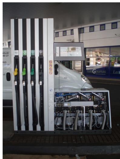
**Figura 2.** Proyectos piloto de implantación de puntos de recarga de vehículos eléctricos y difusión de la movilidad eléctrica (Cantabria) e instalación de sistemas de recuperación de COVs en gasolineras (La Rioja), en el marco del proyecto e-AIRE
