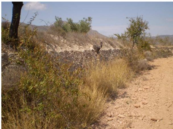
**Imagen 2. Ribazo de piedra o talud que separa terrazas que se encuentran a distinto nivel, dando estabilidad a las paredes de las distintas terrazas.**
