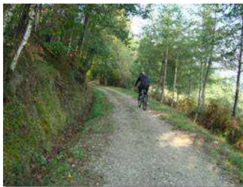
Explanación del ferrocarril
