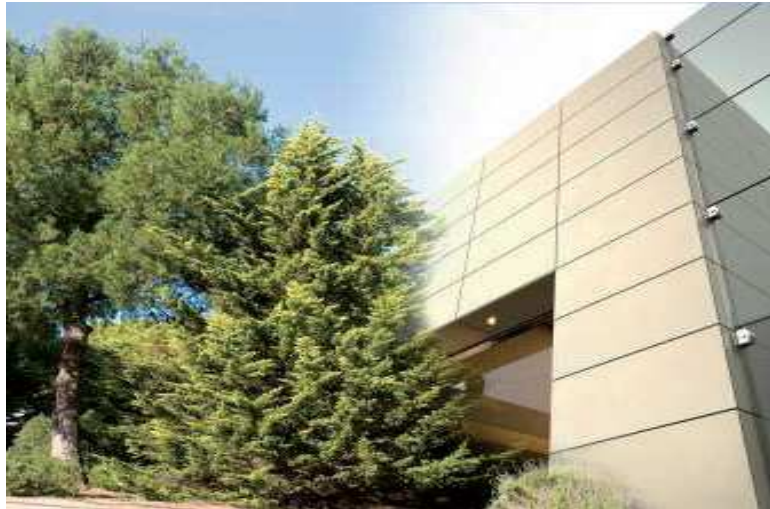
Ejemplo de acabado de revestimiento de fachadas con materiales cerámicos fotocatalíticos
