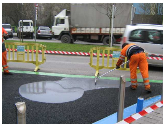
Proceso de extendido y percolación de lechada fotocatalítica sobre un pavimento drenante
