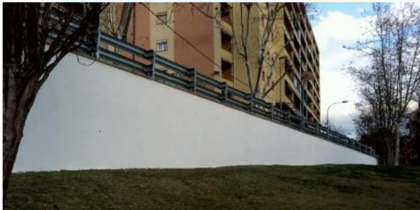
Ejemplo de aplicación de mortero fotocatalítico sobre muros de contención
