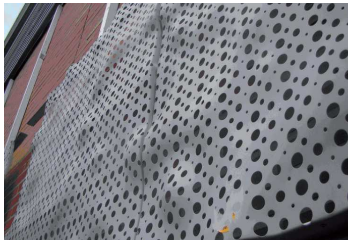
Aplicación de pinturas fotocatalíticas en envolventes metálicas de edificación
