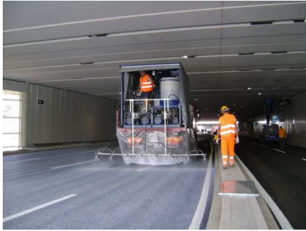
Proceso de pulverización de spray fotocatalítico sobre pavimento existente (Izda.). Detalle de acabado de extendido de spray fotocatalítico en aceras en Milán (Dcha.).
