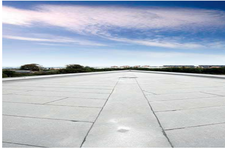
Ejemplo de aplicación de cubiertas de impermeabilización fotocatalíticas en edificios urbanos
