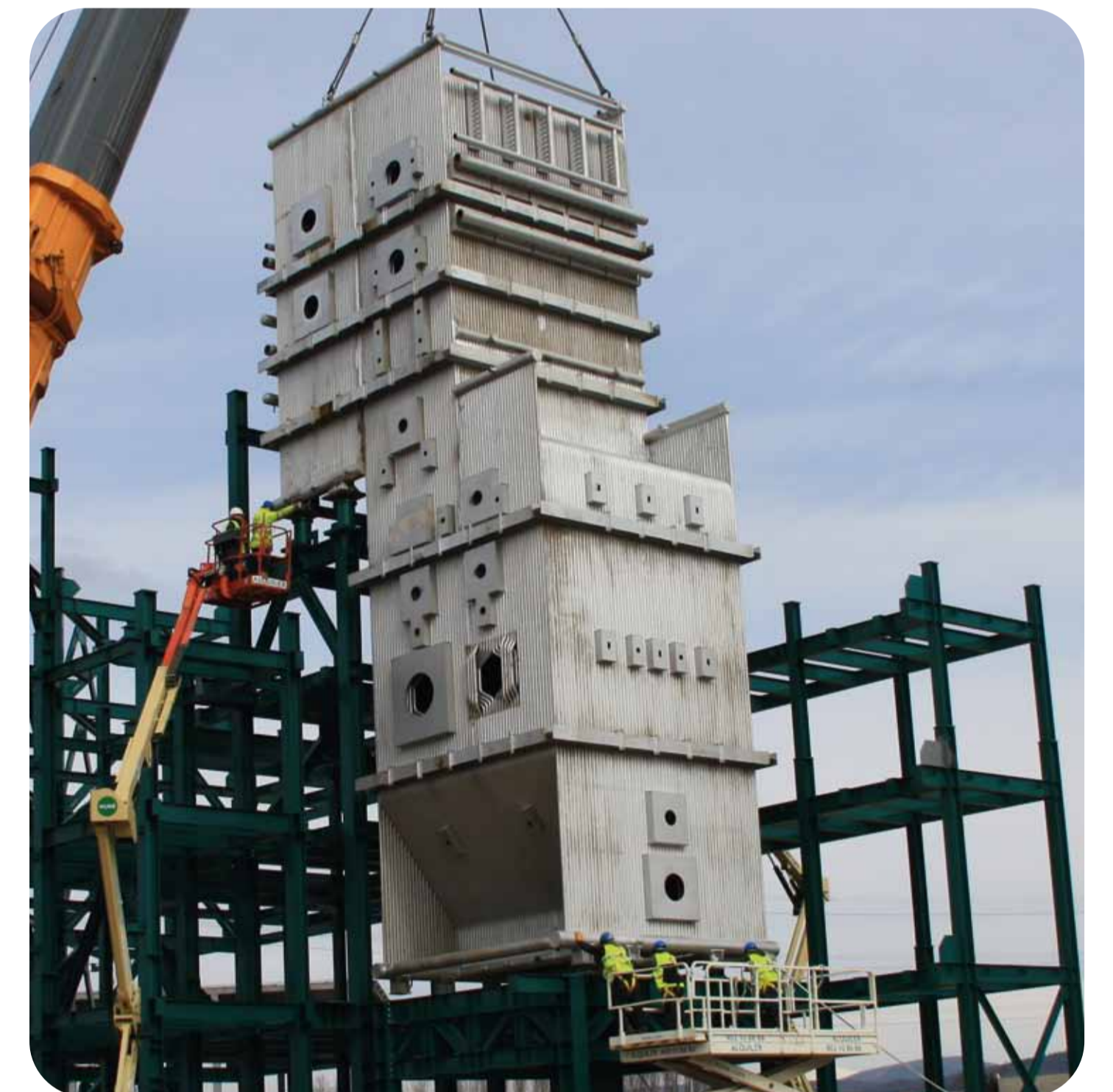
Caldera de carbón pulverizado, construcción (2010)
