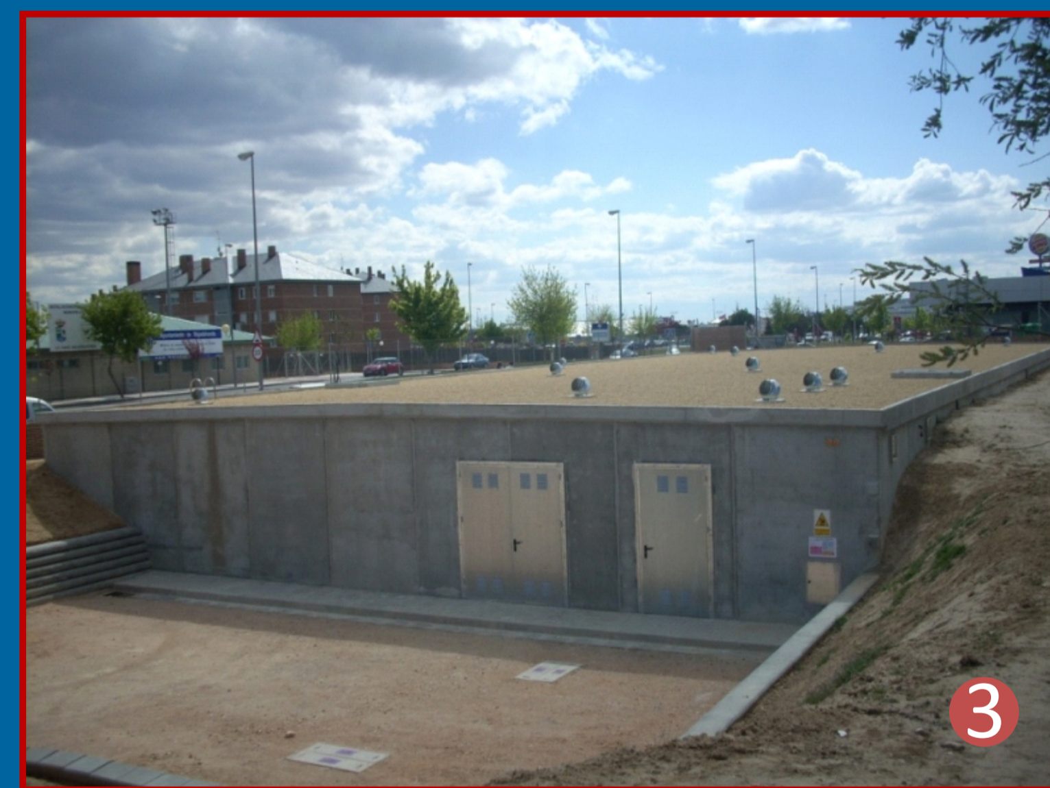
Depósito regulador de agua regenerada
