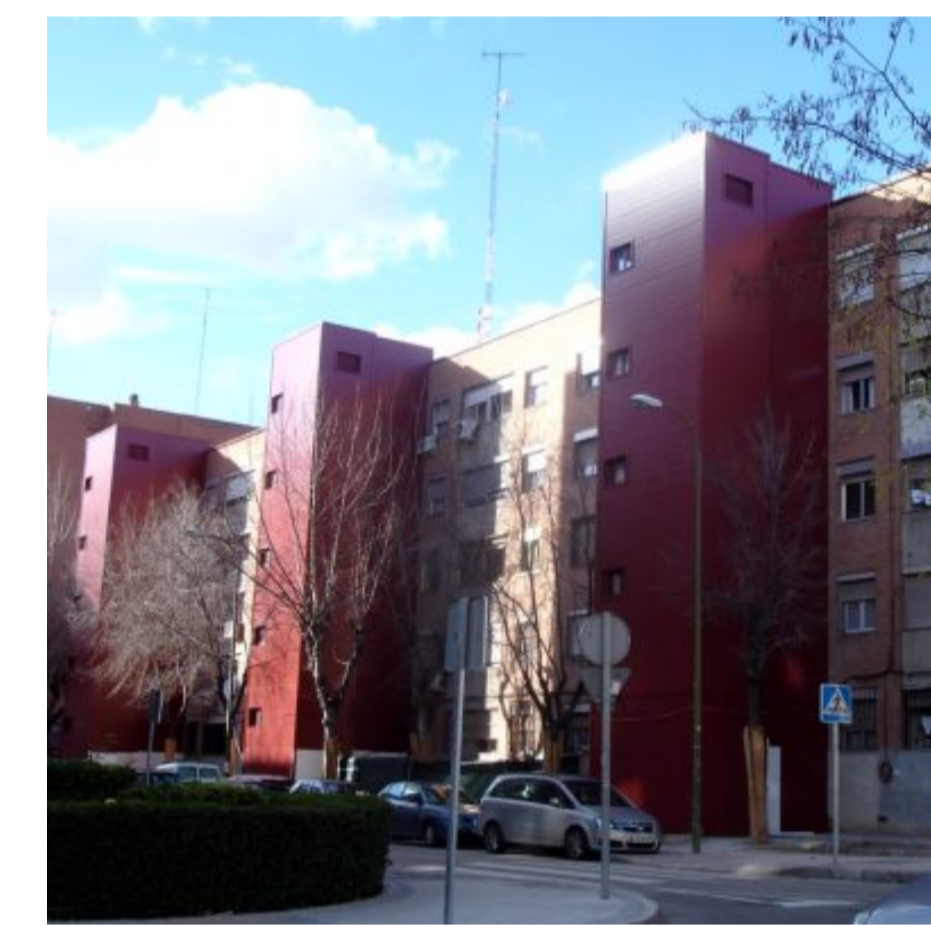
COLONIA EUSKALDUNA. INSTALACIÓN DE ASCENSORES
