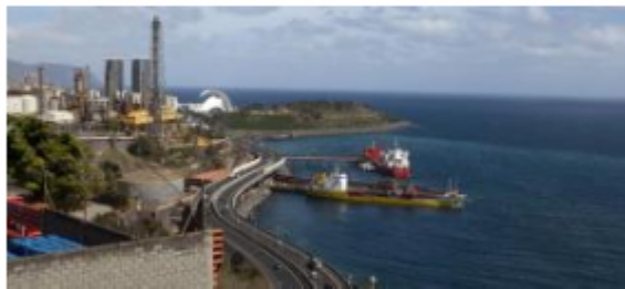
La mancha verdosa en el mar señala el punto donde se vierten las aguas residuales en La Hondura. j. l. gonzález
