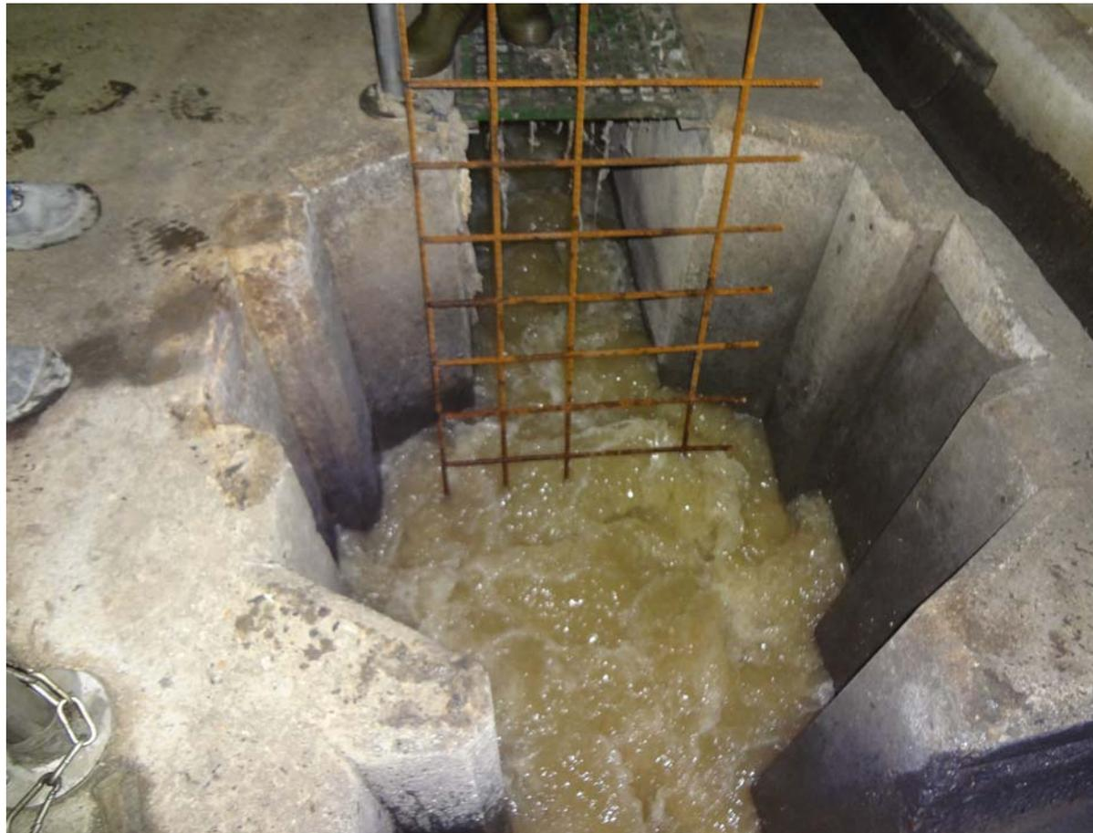
3. En 5 minutos, tras la apertura de la compuerta, el caudal de paso se estabilizó y en la malla se observó la acumulación de trapos y textiles
