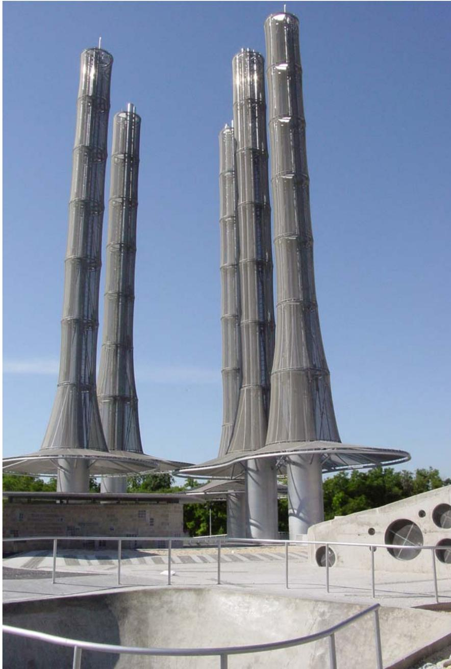
La estructura de acero de las chimeneas está rodeada por un forro textil, a modo de sombrillas, que actúan como chimeneas solares, es decir regulan térmicamente el espacio al producirse un movimiento ascendente por el calentamiento del aire en la parte superior de las chimeneas. Disponen de una iluminación de LEDS con bancos y una zona para juego de niños y jóvenes.
