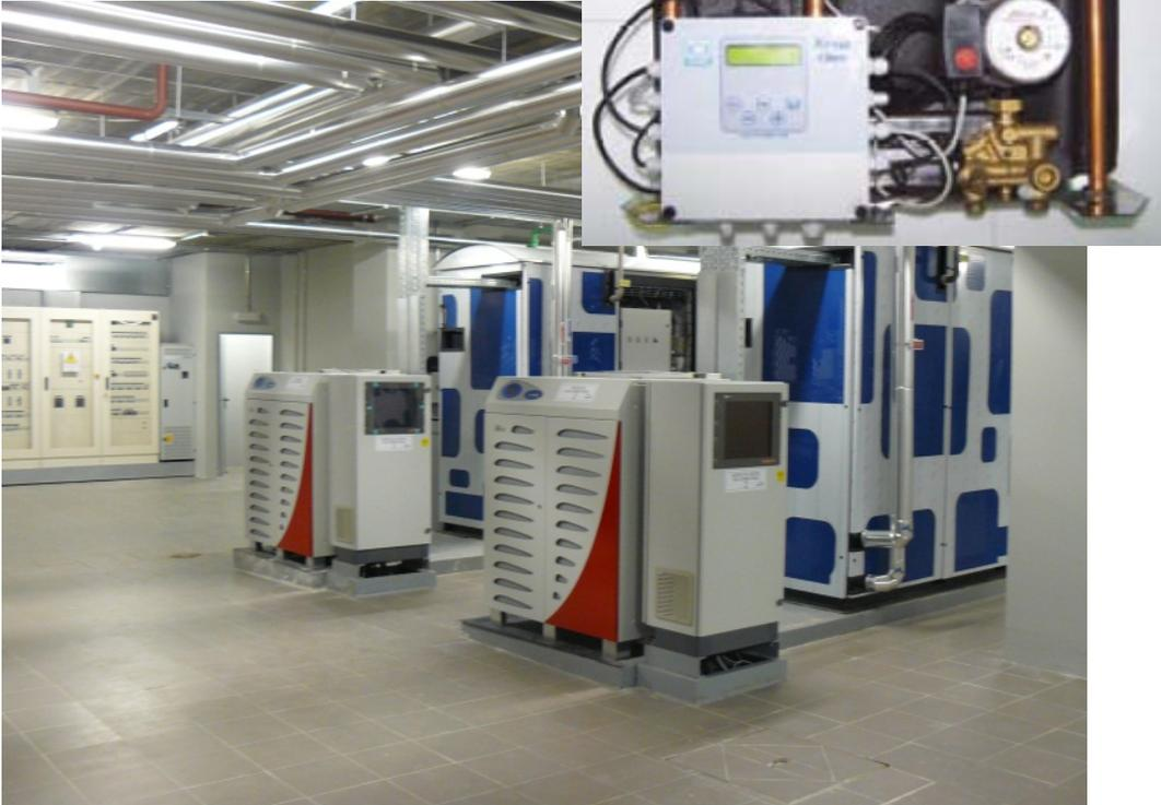
Este sistema de cogeneración mediante la tecnología de “PILA DE COMBUSTIBLE (Hidrogeno)” produce el 70% de agua caliente para ACS cuyo 30% restante es suministrado por las calderas de condensación. Como elemento residual genera energía eléctrica que se utilizará para el autoconsumo de las dos centrales y la restante se disipará en la red general del barrio. Se conseguirá unos ahorros de energía cercanos al 50% y una reducción equivalente de emisiones contaminantes.
