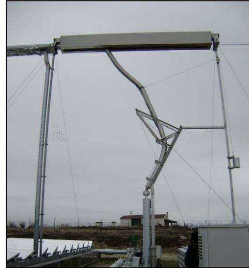
Compensación dilataciones en Puerto Errado 2 (CLF).
