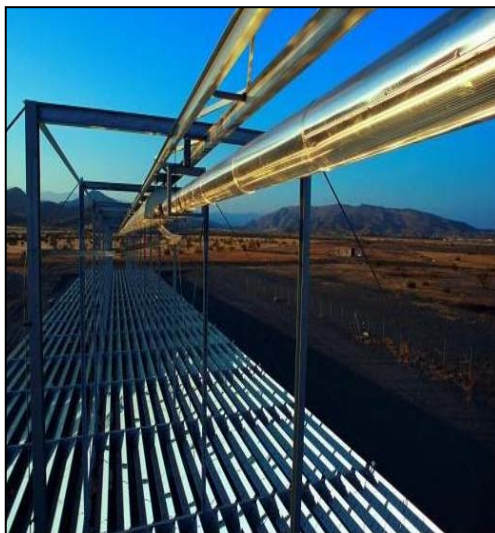
Tubo absorbedor receptor (inmóvil) para el caso de tecnología Linear Fresnel (CLF).
