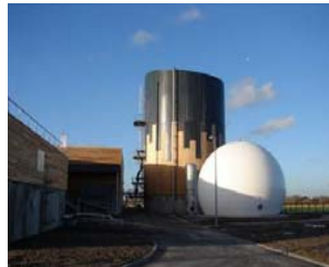
Tratamiento de residuos
