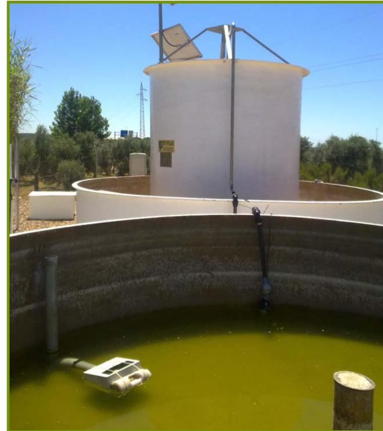
F II: Espesor sustrato filtrante: 1,5 m
