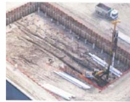
Anclajes para la UF
