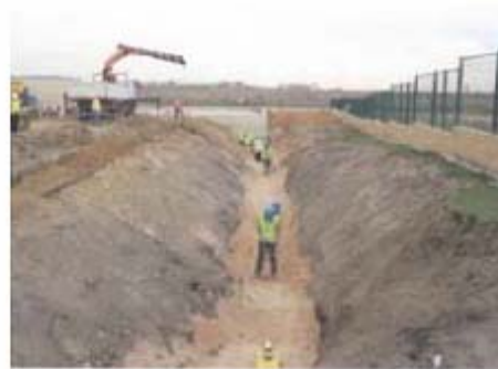
Tubería conexión Holmen-EDAR
