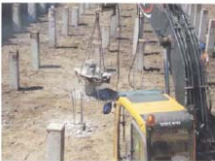
Anclajes para la UF
